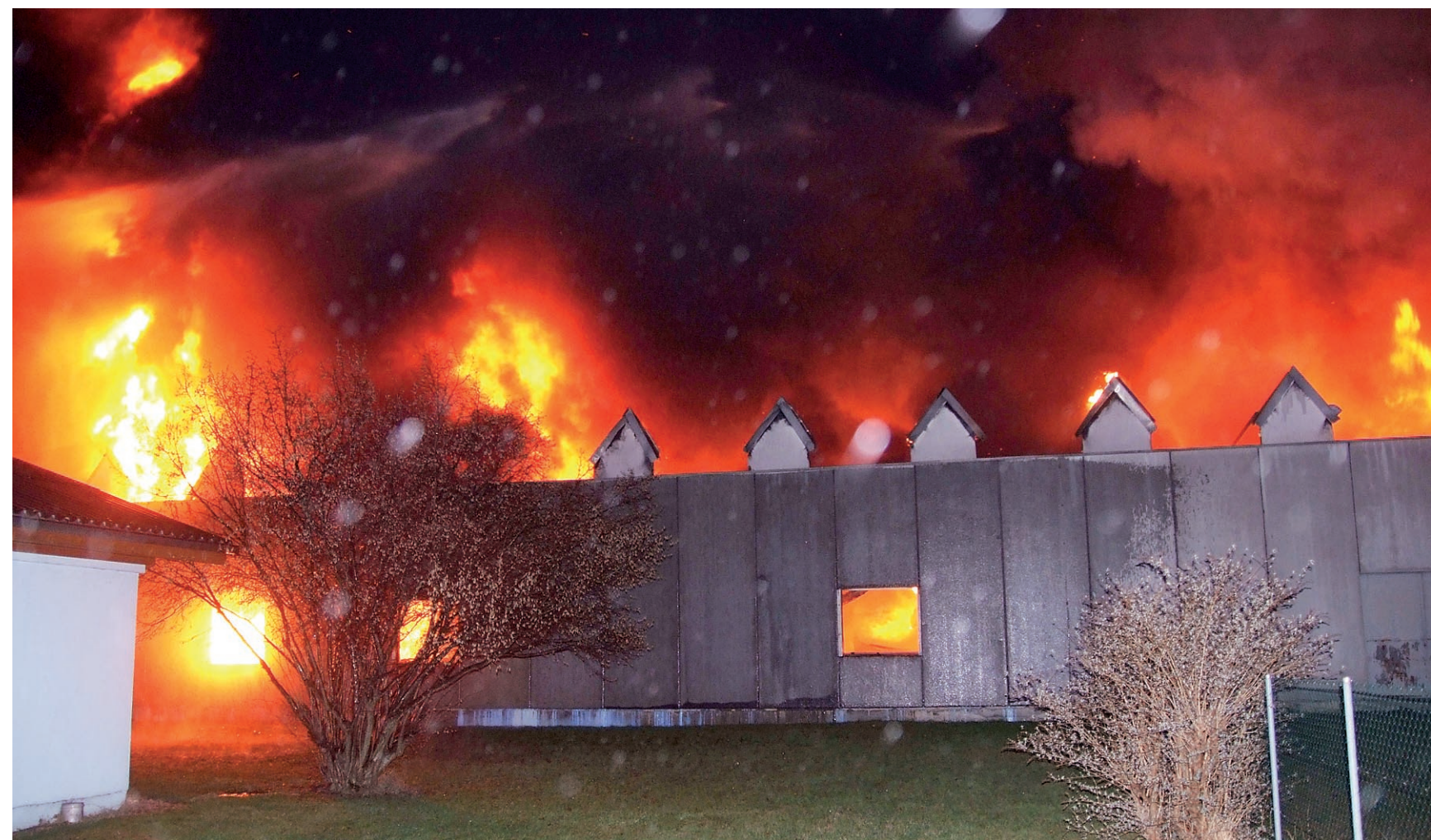
Um etwa 00.35 Uhr bemerkten Anwohner den Brand: Als die Feuerwehr eintraf, schlugen bereits Flammen aus der Fabrikhalle.
